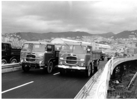
Il collaudo della sopraelevata fu effettuato nel 1965 con l'ausilio di due colonne di autocarri zavorrati (Archivio Publifoto Genova)
